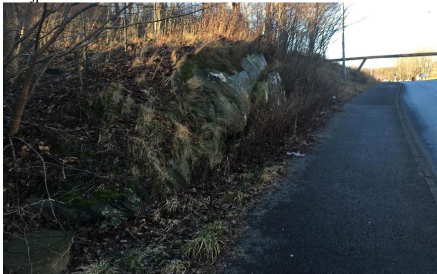
Foto 6. Bergsbranter/skärningar delvis jordtäckta utmed Radiovägens södra del
