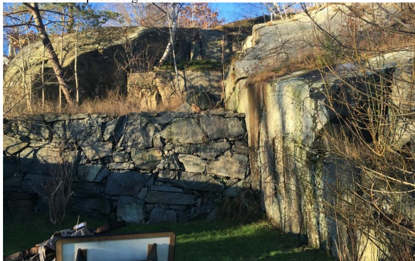
Foto 3. Stenmur som ansluter till sprickfri bergsbrant i väster
